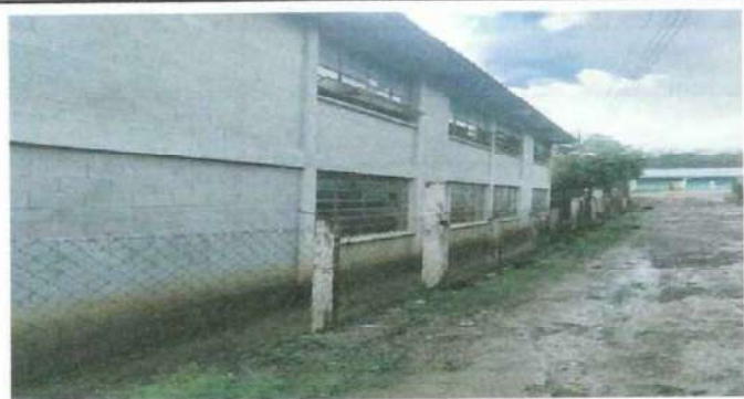
Foto1: Mantenimiento de ventanas y pintura de paredes interior y exterior en el modulo No. 03
