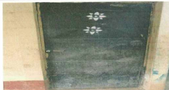
Foto 4: Sustitución de puerta en los modulos No. 1 y 2.
