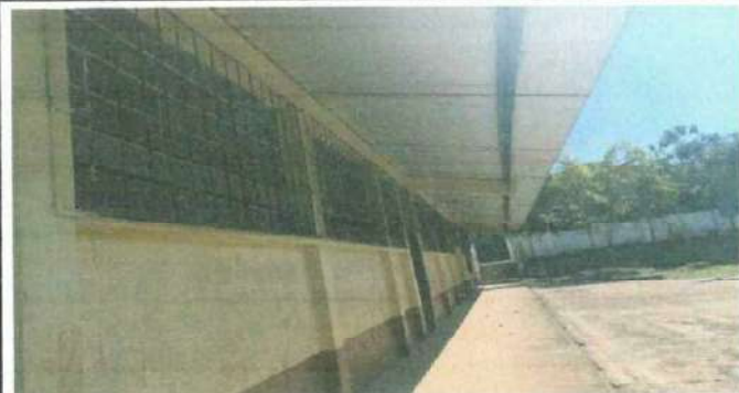
Foto 2: Mantenimiento de balcones, pintura de paredes interior y exterior del modulo No.02
