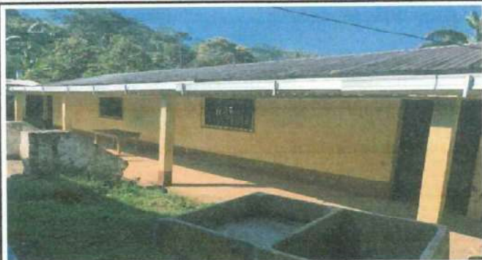
Foto 1: Sustitución de láminas troqueladas a láminas troqueladas Aluzinc calibre 26, sustitución de costaneras y pintura en las paredes del modulo No. 1
